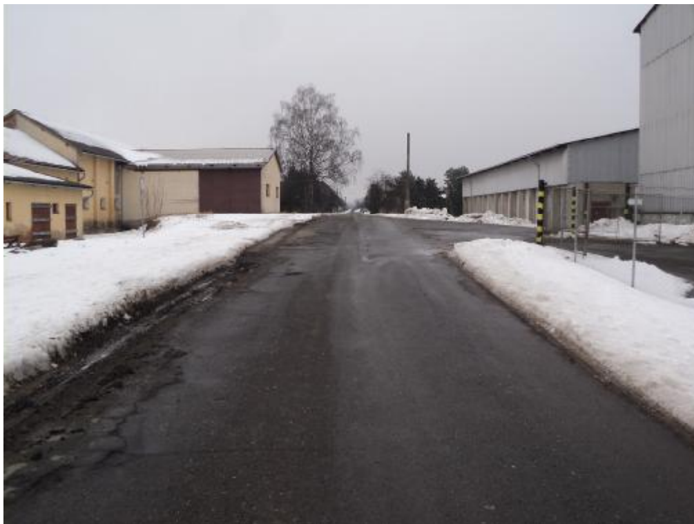
Trhlina široká příčná, olamování okrajů vozovky – km 2,100.
