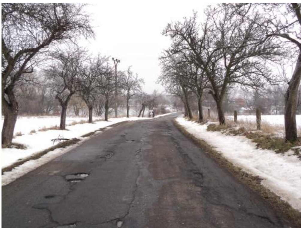
Síťové trhliny, vysprávkky, výtluky v obrusné vrstvě a krytu – km 1,700.
