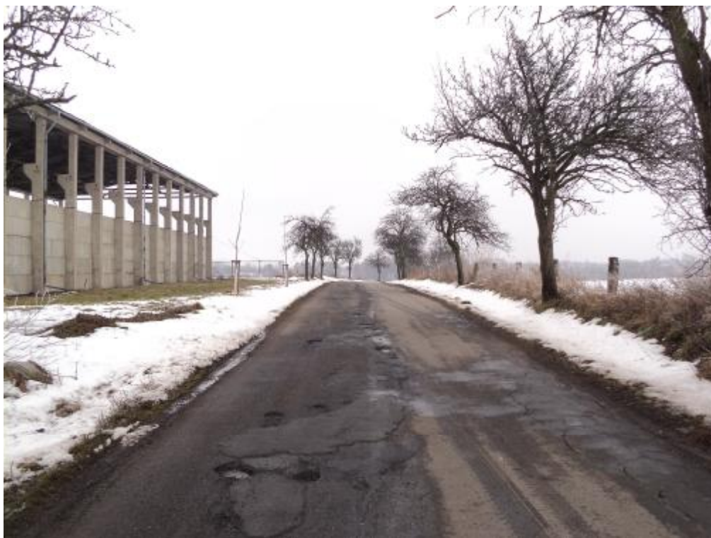
Olamování okrajů vozovky, vysprávkky, výtluky v obrusné vrstvě a krytu – km 1,300.
