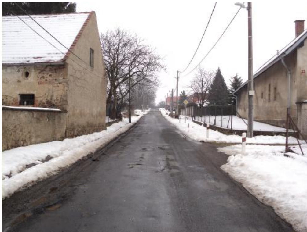
Výtluky v obrusné vrstvě a krytu, síťové trhliny – km 0,100.
