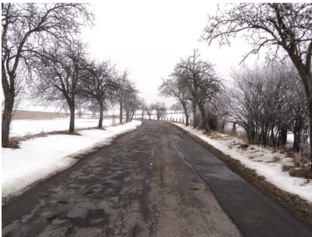
Síťové trhliny, vysprávkky, výtluky v obrusné vrstvě a krytu – km 0,900.
